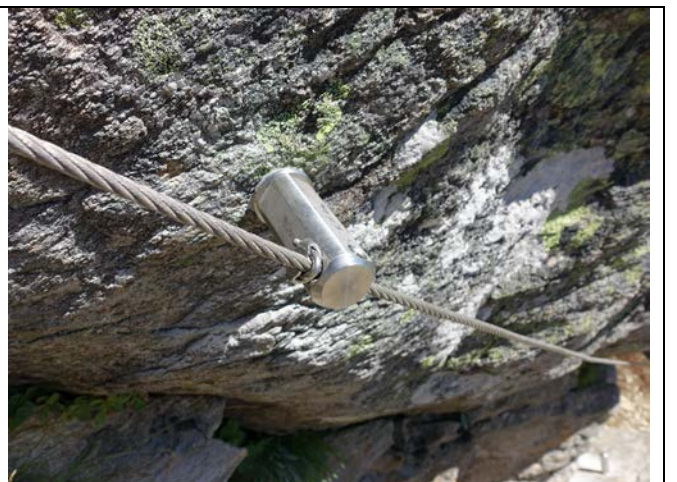
Neues Stahlseil am Tritt
